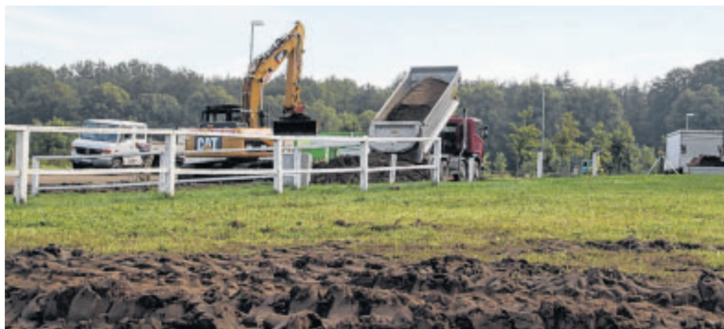
Mittwoch: Es läuft wie am Schnürchen – Schlamm wird abtransportiert, neuer Sand aufgeschüttet.
